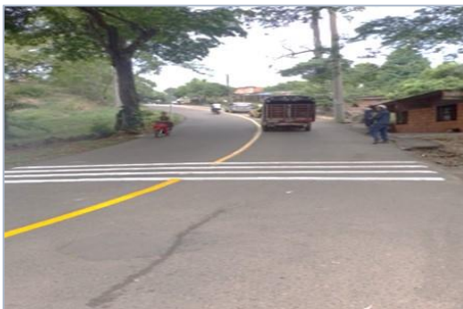
Bandas reductoras de velocidad y línea de carril, Barrio Buenavista – Comuna 4
