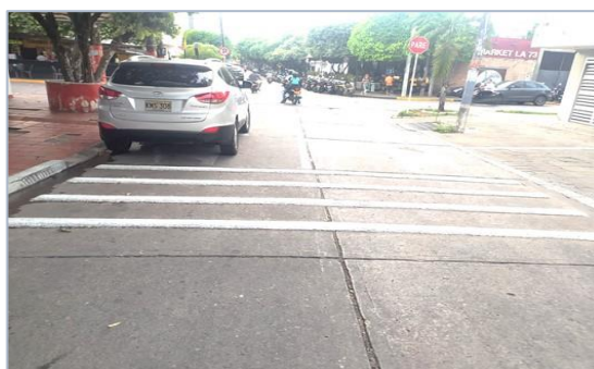
Bandas reductoras de velocidad y señalización, Barrio La Libertad – Comuna 3
